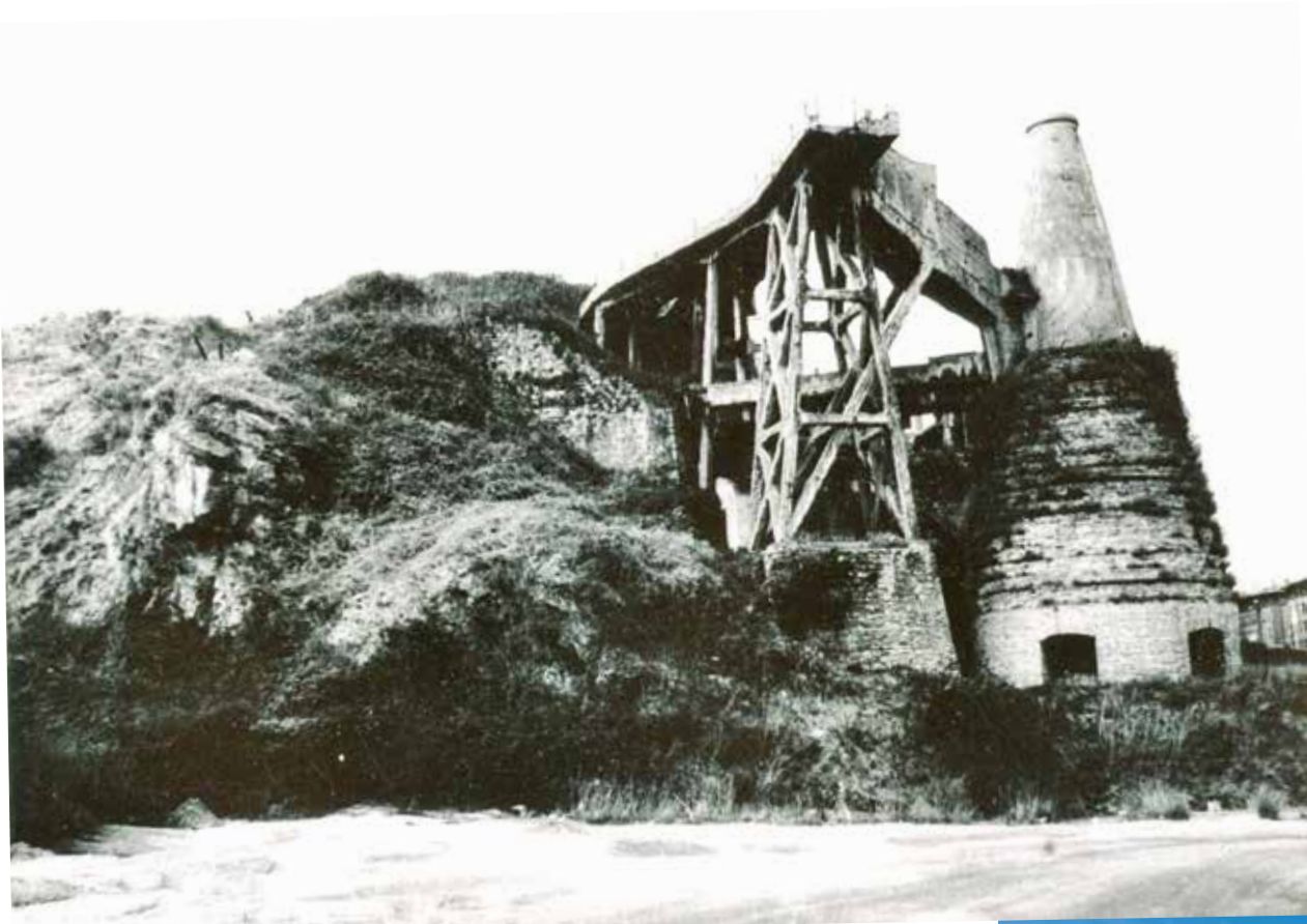
Horno de calcinación de la Mina San Luis
